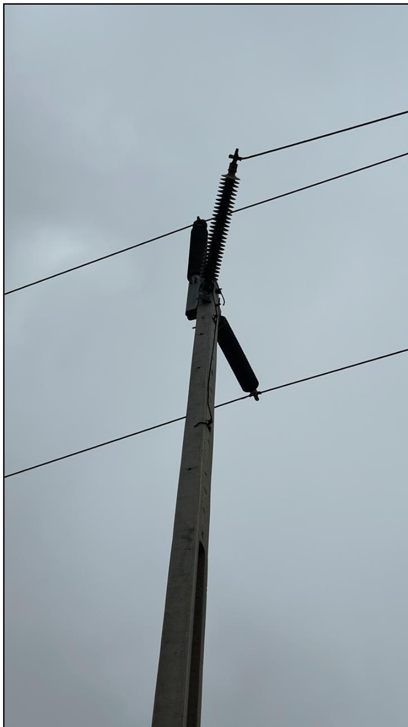
Fotografía 2 – Postación de Conductor Cortado
