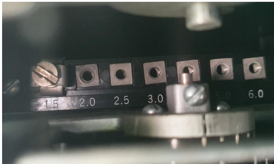
Fotografía 5. Ajuste de TAP relé electromecánico de neutro modelo GE. (I2IAC51B86A).
