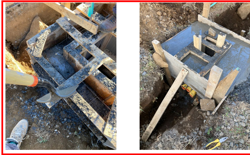
Imágenes: Destacado en ROJO se observa el hormigonado de cámaras C1, y C2.
