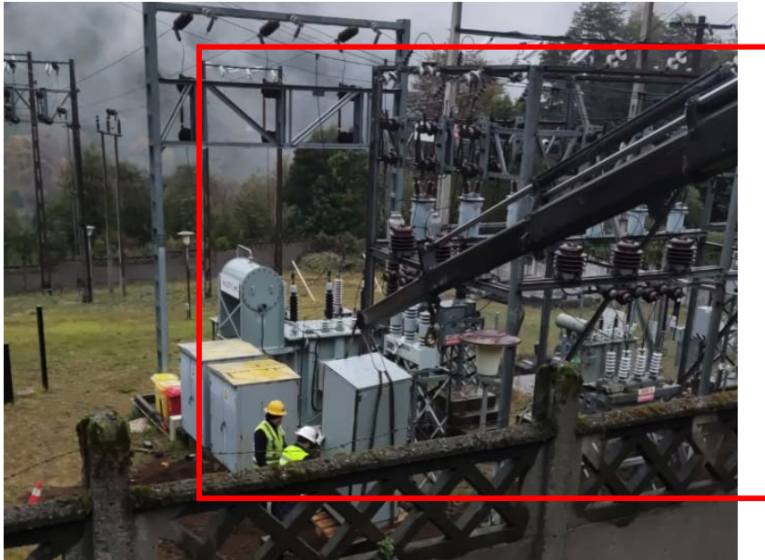
En la imagen destacado en ROJO se observa el izaje por medio de camión Pluma del armario de protecciones para darle ingreso a la subestación
