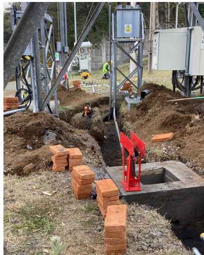
En la imagen anterior se observa el proceso de instalación de nueva Canalización.
