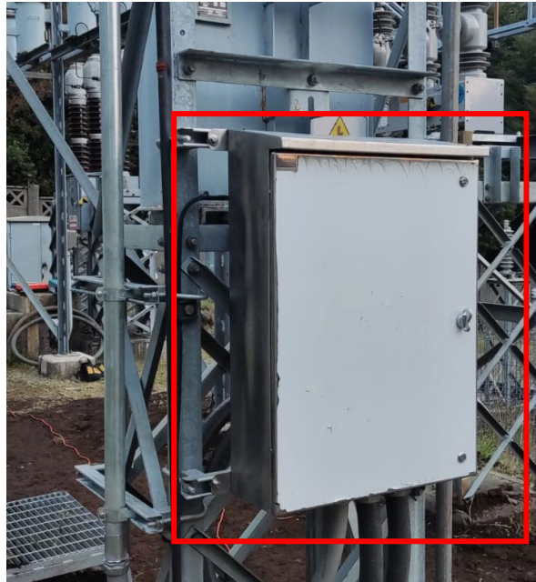
En la imagen se observa el montaje y fijación del Nuevo Tablero de Servicios Auxiliares.
