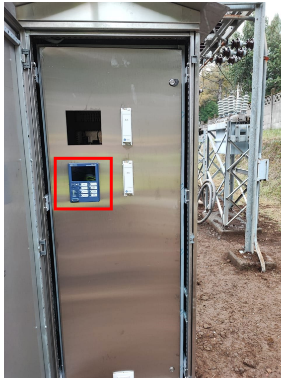
En la imagen se destaca en ROJO el montaje de la nueva protección SEL-751.
