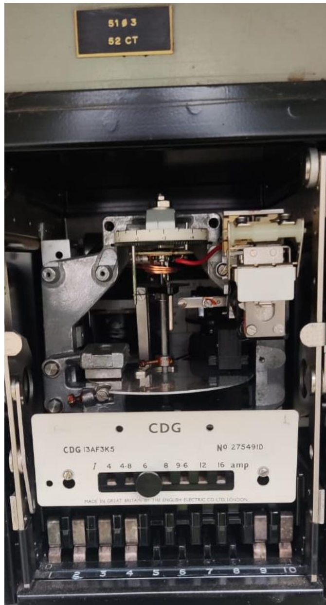
Fotografía 1. Ajuste de corriente secundaria relé electromecánico de fases modelos CDG.
