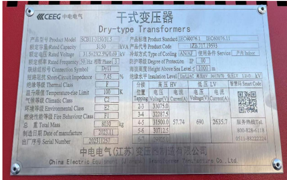
Figura 7.11 – Placa del transformador de bloque
