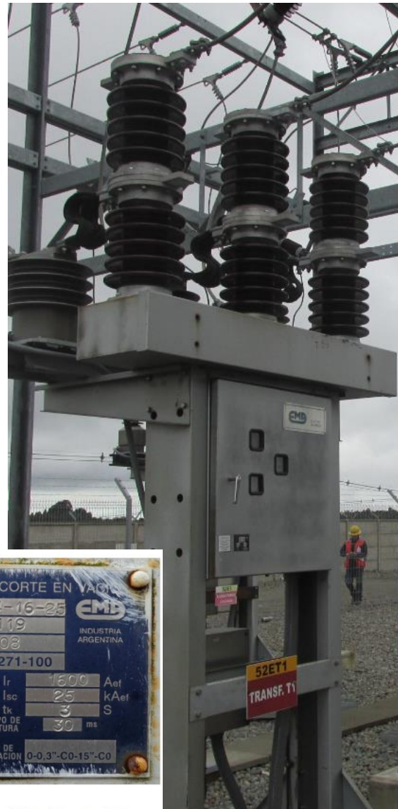
Figura 1: Placa característica Interruptor.
