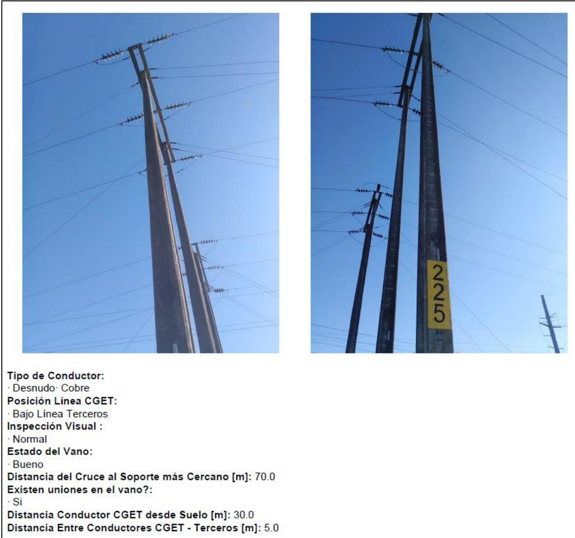
**Figura 1.2.-** Extracto del informe de inspección al vano entre E225 y E226.
