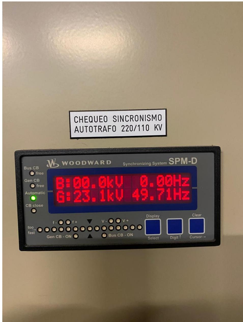
Figura 4.3 – ABB – Modelo WOODWARD SPM-D Control de sincronismo
